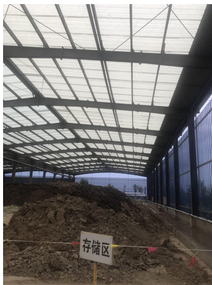
料场顶棚防雨遮阳、柔性防尘网
